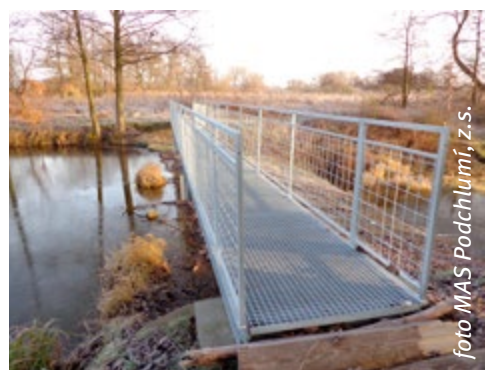
Lávka v Dobré Vodě u Hořic
